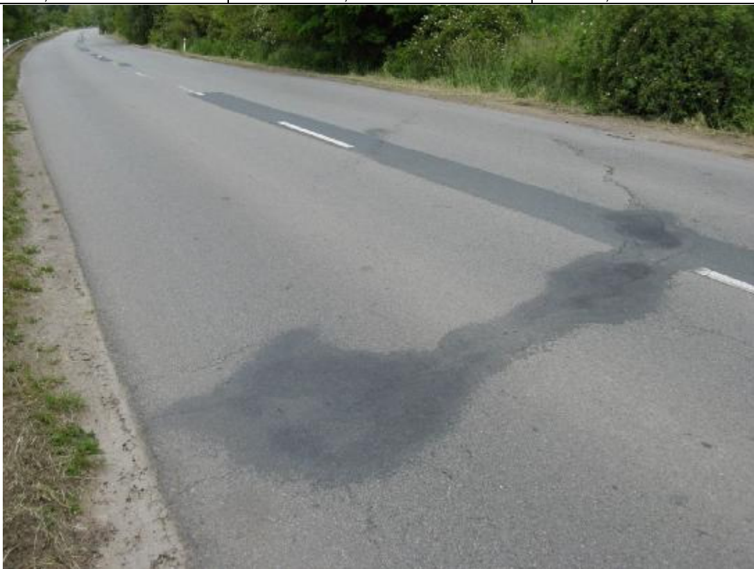
F31A, km 9,180- Dvě příčné rozvětvené trhliny.
