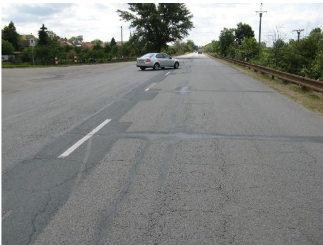
F59, km 10,510+ Mozaikové trhliny a příčné rozvětvené trhliny.
