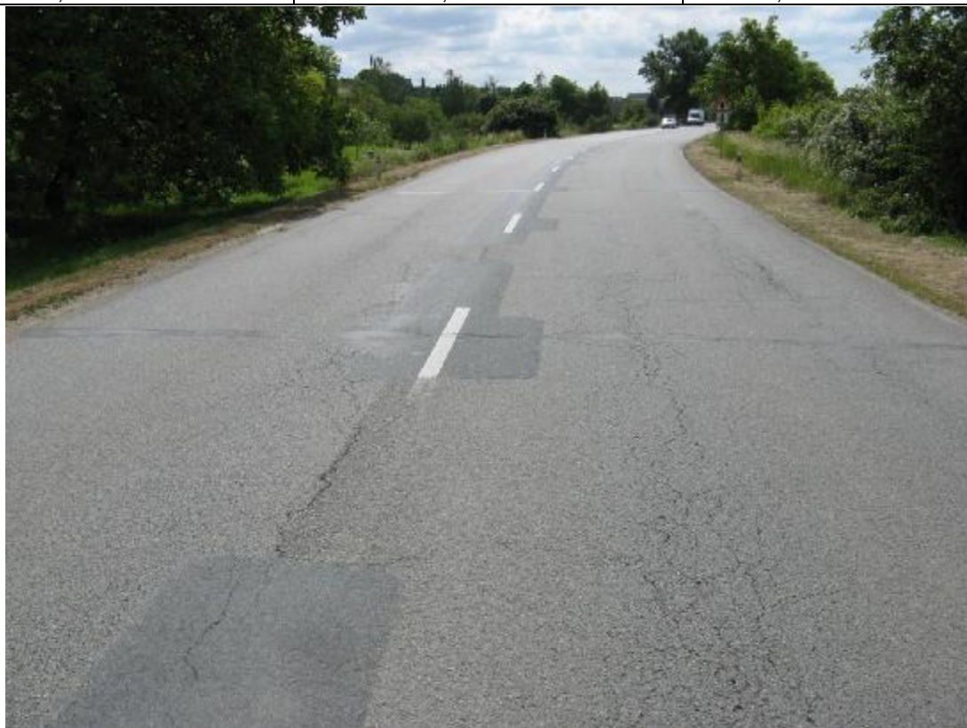
F55, km 10,310+ Mozaikové trhliny a příčné rozvětvené trhliny.
