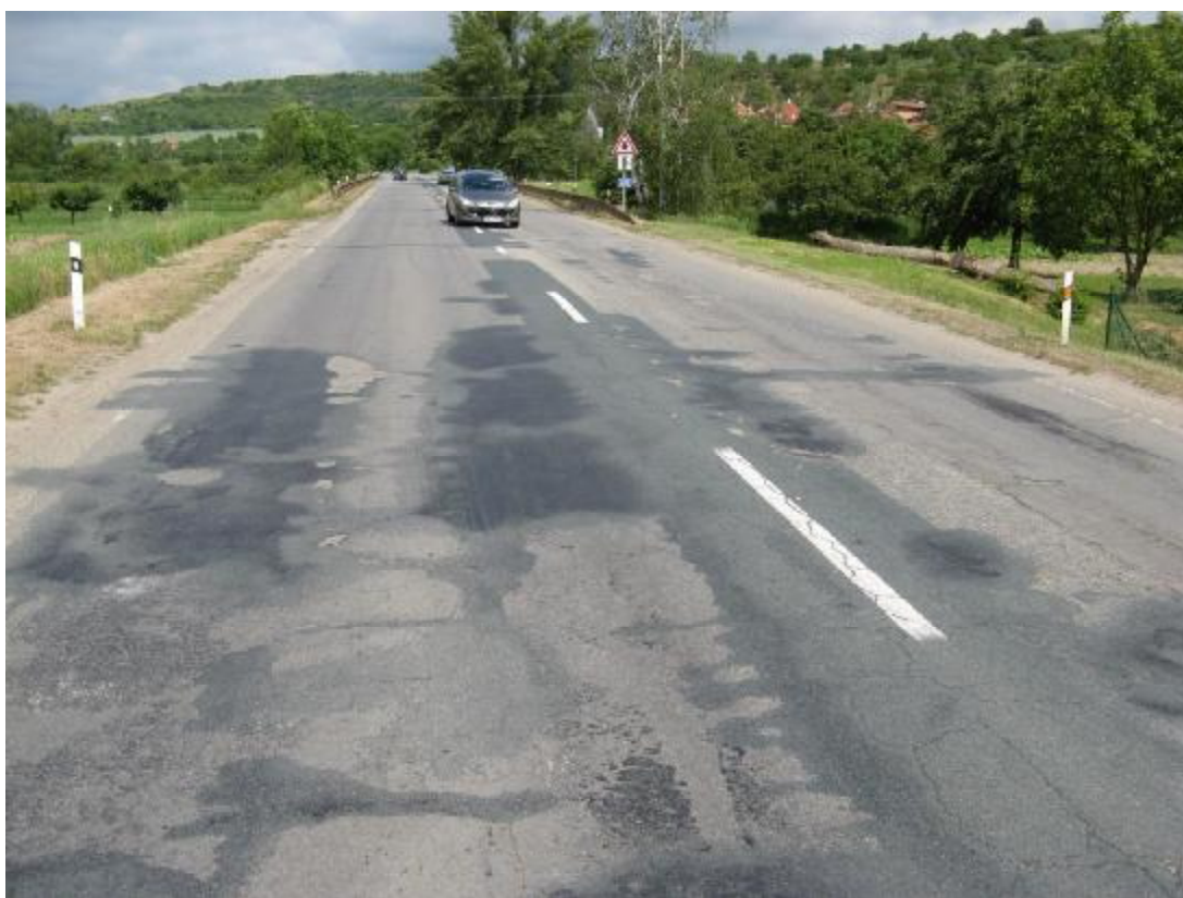
F62, km 10,700- Koroze EKZ, vysprávkvy tryskovou metodou, nepravidelné hrboly.
