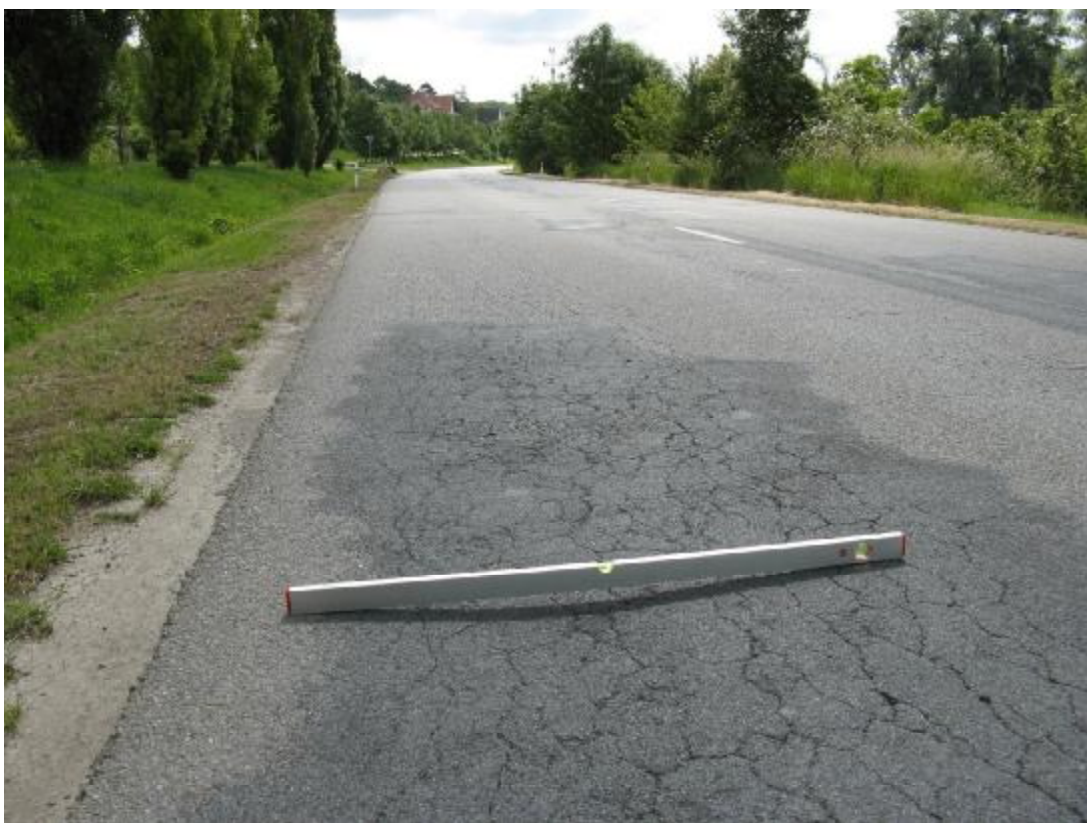
F49, km 10,005+ Síťové trhliny.
