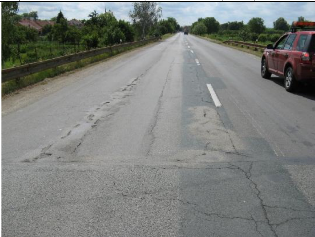
F61, km 10,595+ Začátek povrchu s korozí EKZ a vyjetými kolejiemi.
